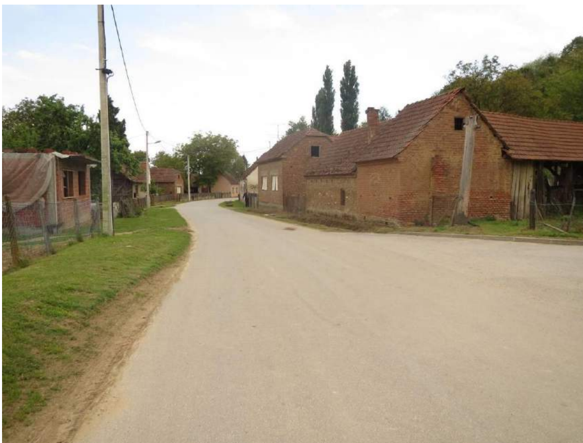
Slika 6. Dio lokacije zahvata – postavljanje cjevovoda
