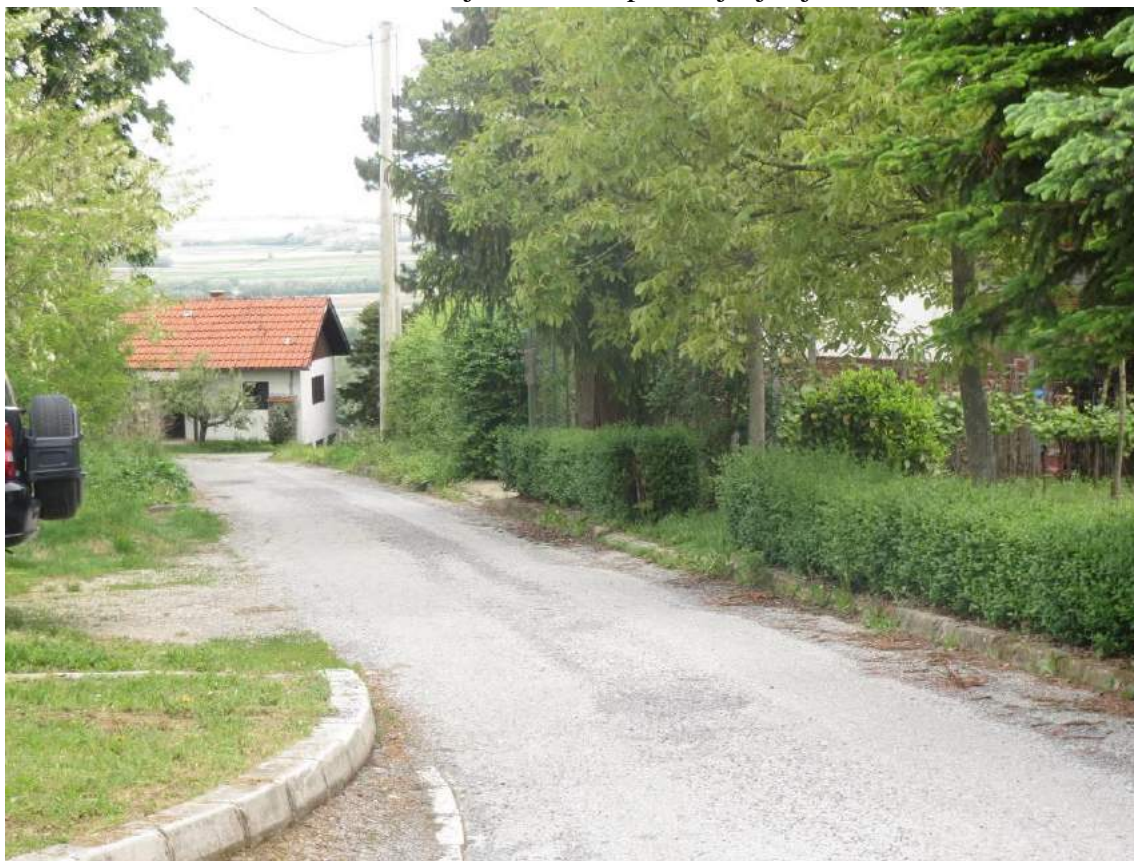
Slika 7. Dio lokacije zahvata – postavljanje cjevovoda
